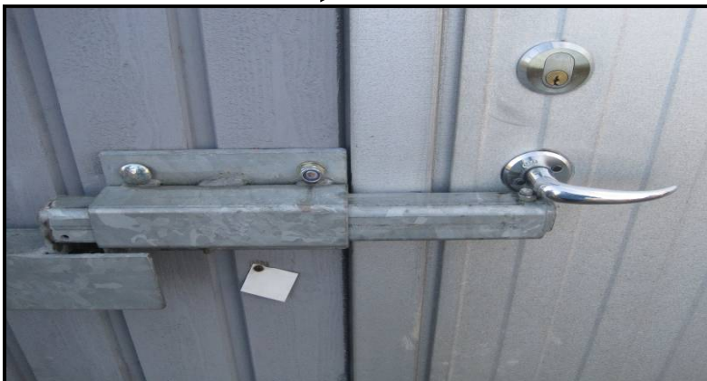
Montering af en metaldækplade omkring låseenhederne på dør, med ekstra aflåsning med hængelås.
