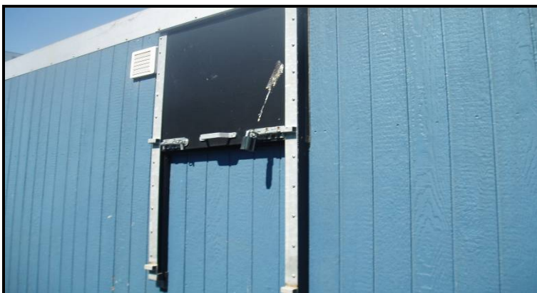
Montering af udvendige aflåselige skodder med hængelås.
