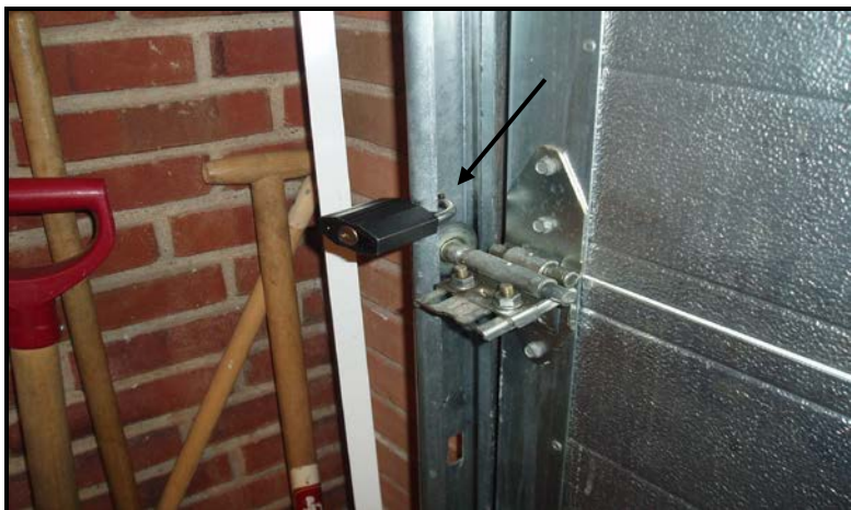
Aflåsning af port med en hængelås klasse GRØN i styreskinnen.
