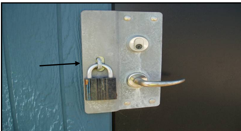
Montering af en metaldækplade omkring låseenhederne på dør, med ekstra aflåsning med hængelås.
